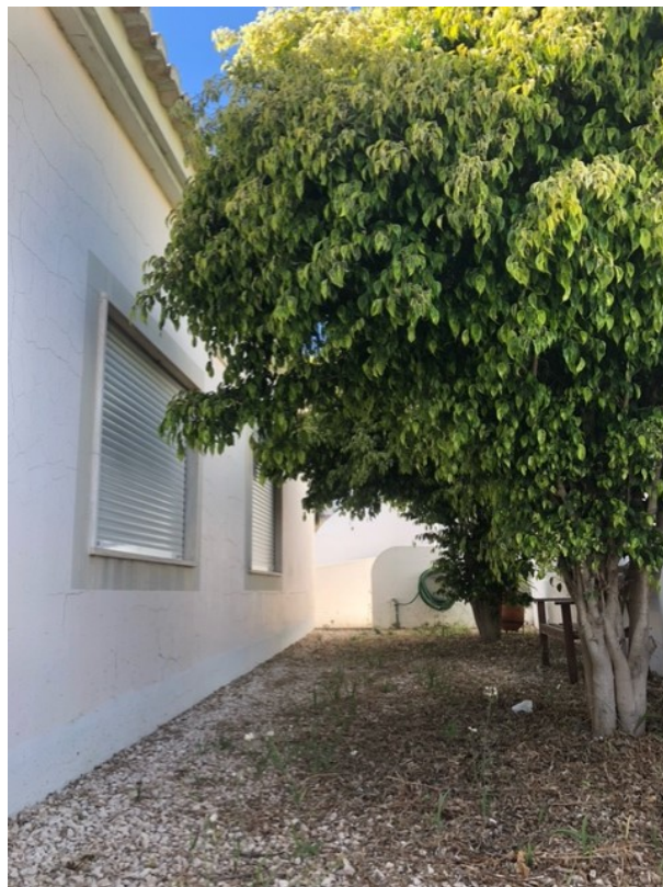
Figura 3.11: Sombreamento com recurso a vegetação na fachada este da moradia em estudo.
