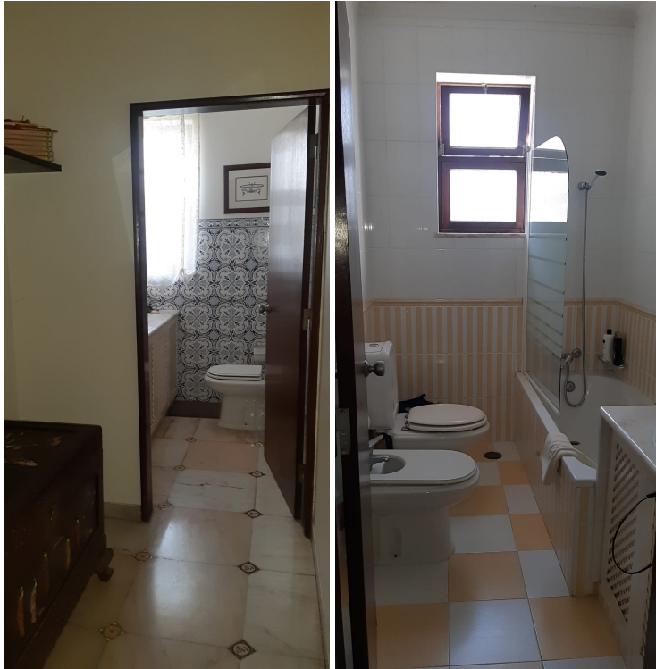
Figura A.7: Instalação sanitário no rés-do-chão (à direita) e no primeiro andar (à esquerda), da moradia em estudo.
