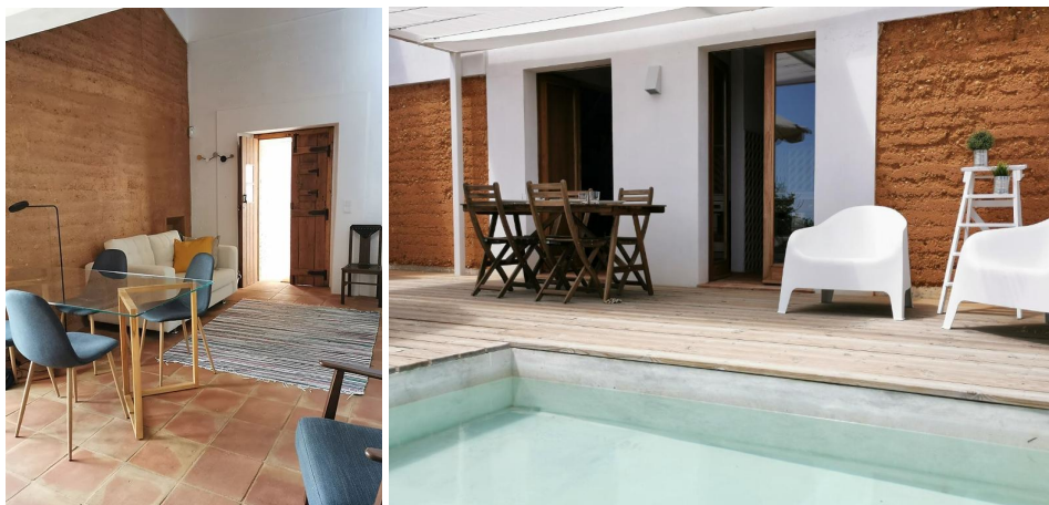
Figura 2.8: Exemplo de construção em taipa no Algarve. Fonte: Casas de Taipa
