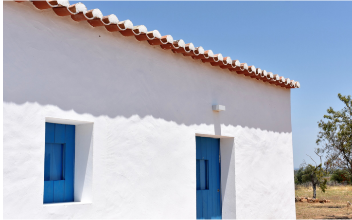
Figura 2.6: Exemplo de revestimento reflexivo da envolvente e beiral no Algarve. Fonte: Morgado do Quintão
